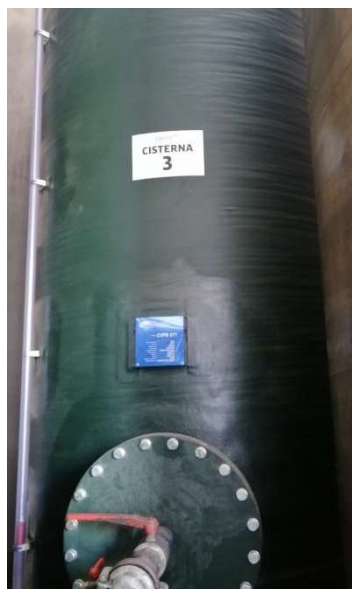
Nuova cisterna installata in data 08/03/2024
