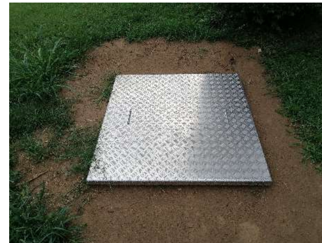
Nuovo pozzetto di campionamento SF3
